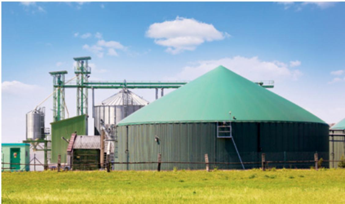
**Eine Biogasanlage liefert bei der Stromerzeugung überschüssige Wärme an die EAG in Form von 82 Grad heißem Wasser. Damit wird im Sommer der komplette Wärmebedarf abgedeckt.**
